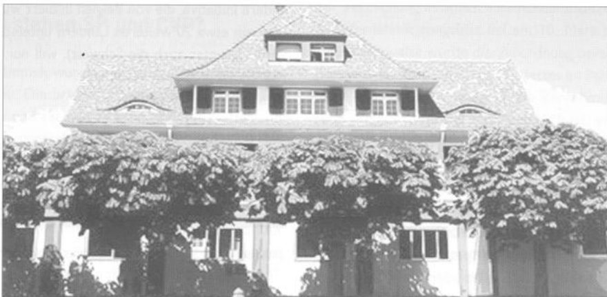
Die psychiatrische Klinik «Hohenegg» in Meilen soll geschossen werden. (Bild: dachtuescher.ch)
